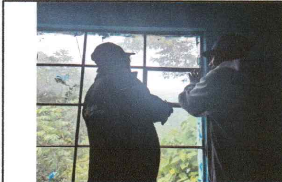
Foto 3: Ventanas, sustitución de vidrios
